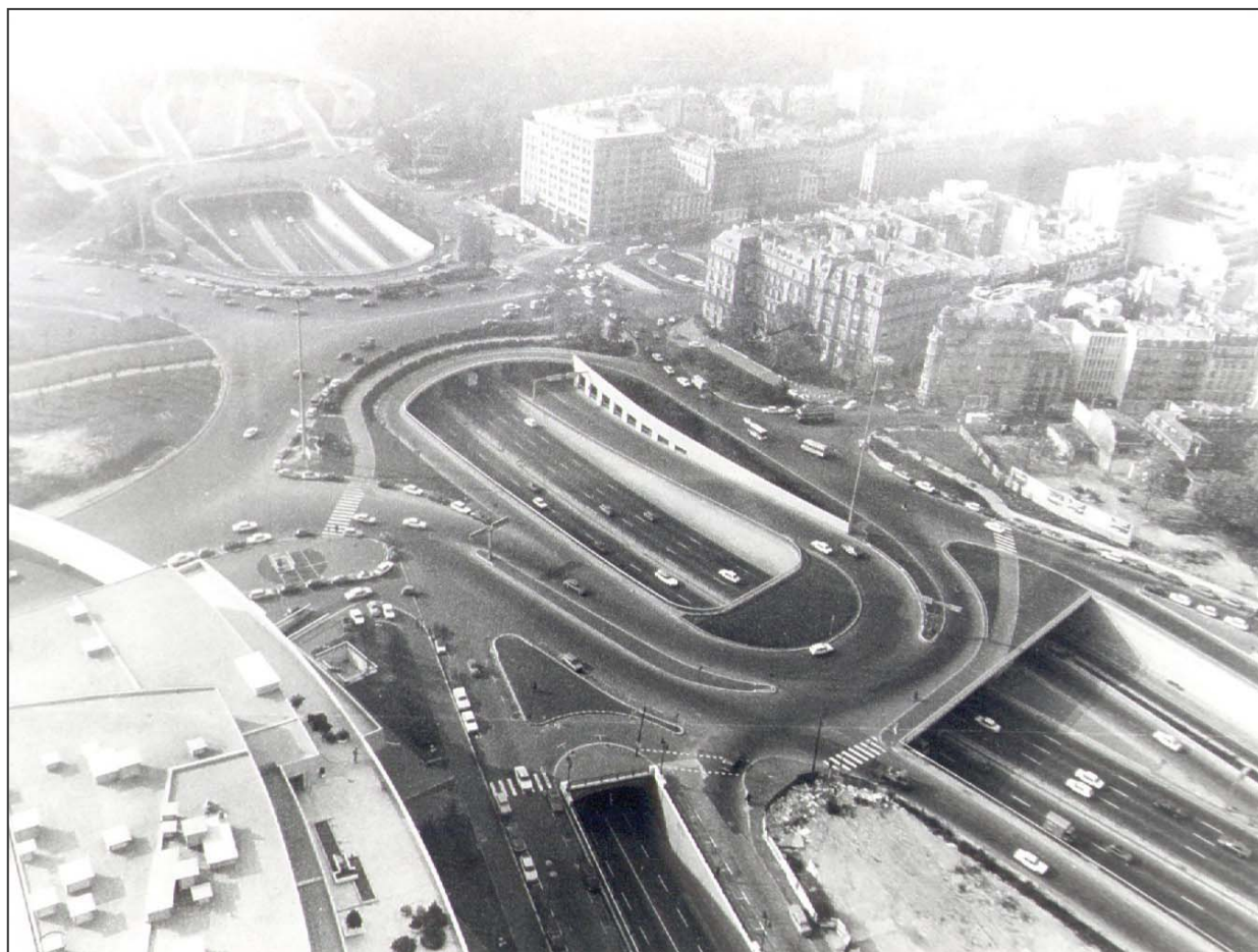
Ouvrages sur Boulevard Périphérique, Porte Maillot à PARIS
